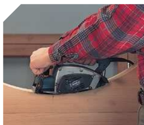
Cepillado de superficies cóncavas.
